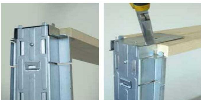
**8** Вставте кінець дерев'яної вертикальної стійки на направляючу і поверніть за допомогою плоскогубців закріплювальні кліпси.
